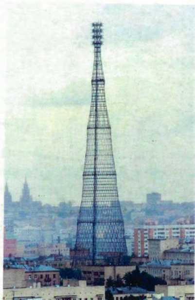
Рис. 28.6. Владимир Шухов. Башня на Шаболовке (Шуховская башня)
