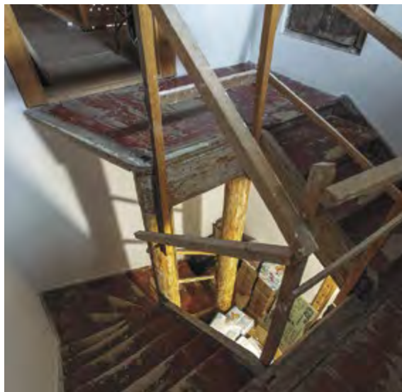
Деревянная винтовая лестница
