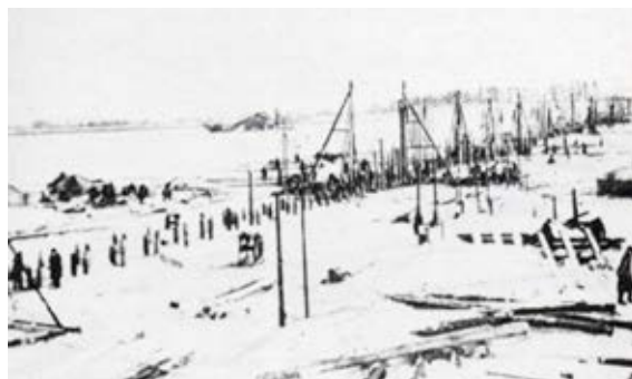
Строительство низководного свайно-левого моста через Неву у Шлиссельбурга
