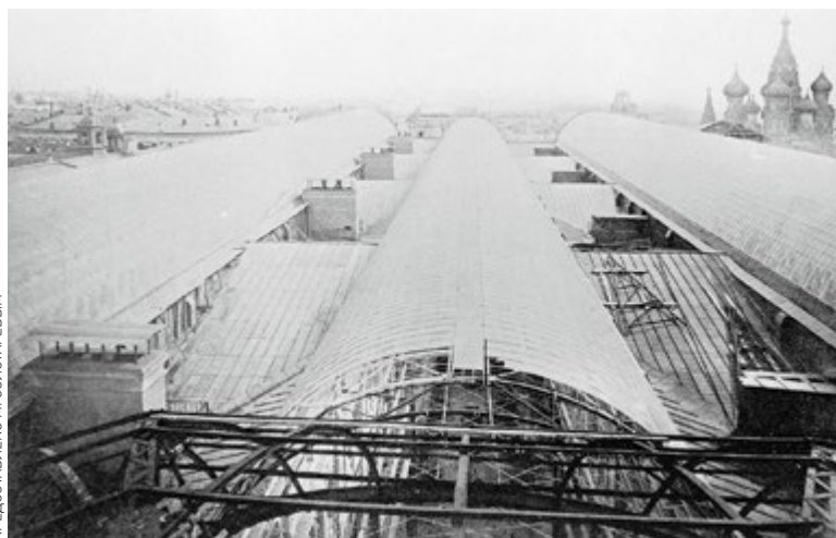
Устройство стеклянной крыши над галереями нового здания Верхних торговых рядов
